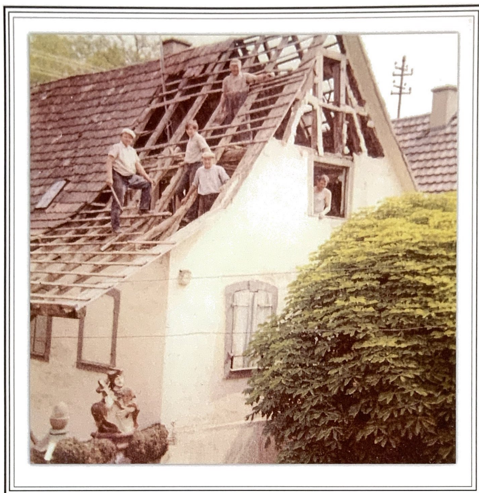
Dachdeckerarbeiten im Jahr 1972 in der damaligen Hauptstraße (jetzt Prof.-Hubbuch-Str. 60). Von links: Josef Zabo, Herbert Frank, Bernhard Muffler, oben: Josef Frank, am Fenster: Franz Frank
