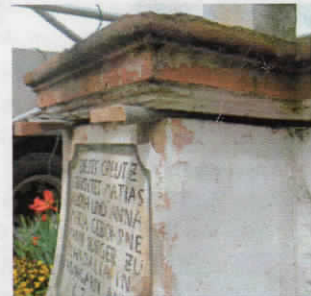
Der zerstörte Sockel des Kreuzes
