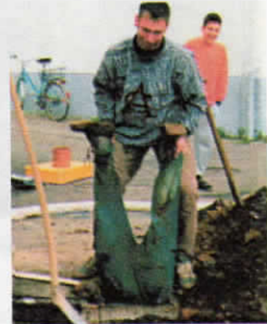
H. Hubbuch und V. Oestreicher bei Kanalsanierungsarbeiten
