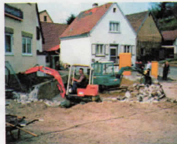
Abriss des ehemaligen Brandweihers
