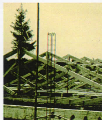
Richtfest nach dem Brand
