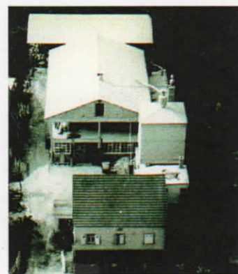
Luftaufnahme der wiederaufgebauten Schreinerei
