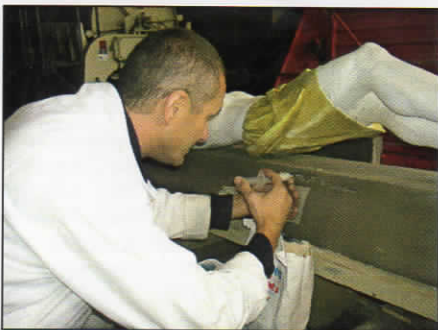
Norbert Repitsch hat die richtigen Füllstoffe für den weichen Maulbronner Sandstein parat
